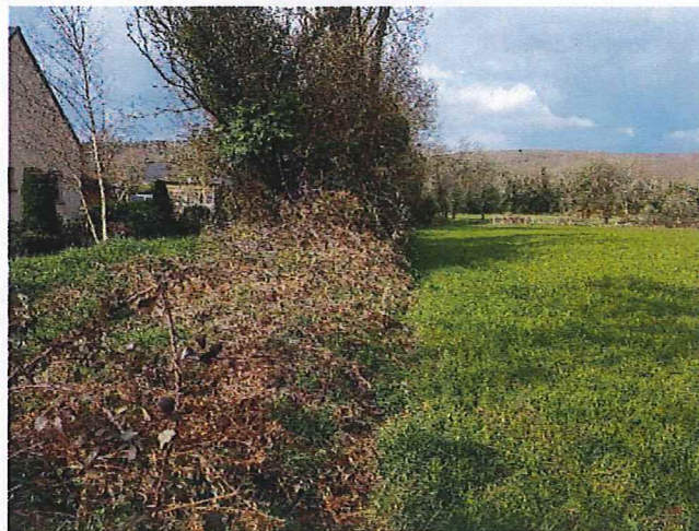
Fossé d'écoulement le long ZA 124
