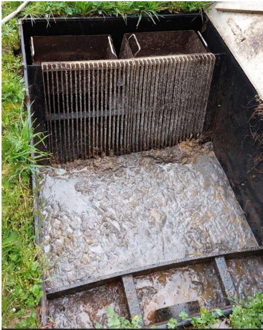
Figure 6 : Grille manuelle de secours
