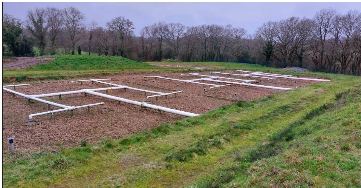
Figure 10 : Premier étage de lits plantés de roseaux
